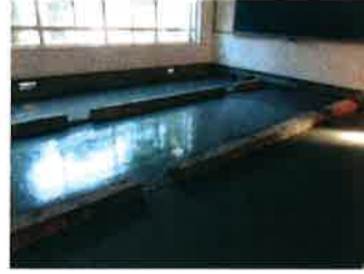
防湿土間コンクリート打設
