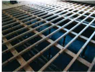
静岡県産材 床組完了
