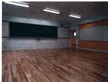
国産ナラ材 フローリング完了
