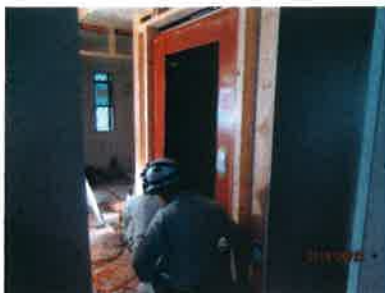
エレベーター設置工事
