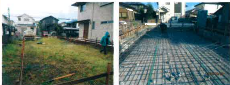
配筋工事⇒配筋検査⇒建方(上棟)⇒竣工⇒お引き渡し
