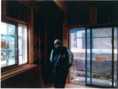
躯体検査実施
