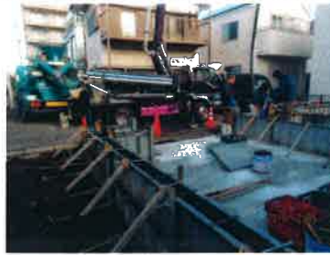
配筋生コン打設
