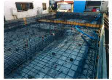
配筋生コン打設
