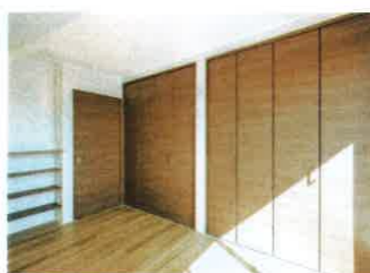
寝室には壁一面に大容量収納を。扉の横には高さが調整できて使いやすい棚を職人が造作した
