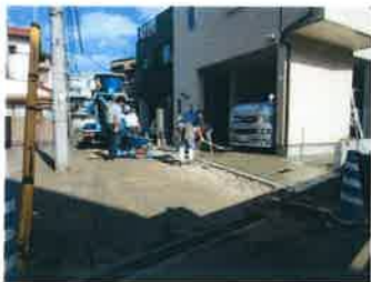
カーポート前生コン打設
