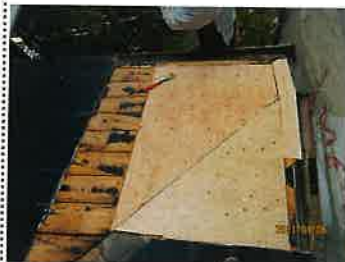
屋根改修工事 腐食部分補修下地
