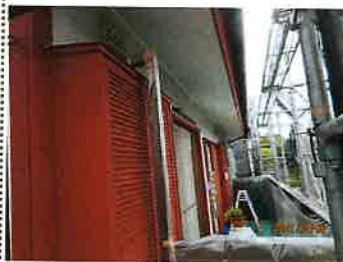
塗装工事 外壁 雨戸 戸袋下塗
