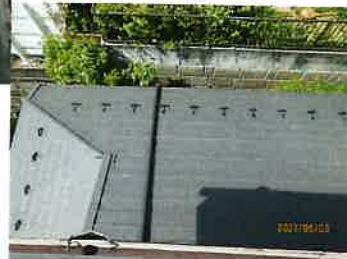
屋根葺替仕上
