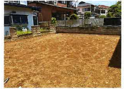
解体後の更地
