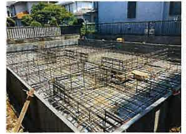
基礎配筋工事
