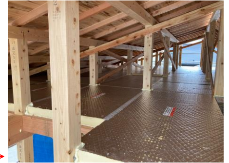
スーパーウォール断熱パネル施工→
