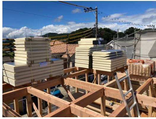
↑スーパーウォール断熱パネル施工↑
