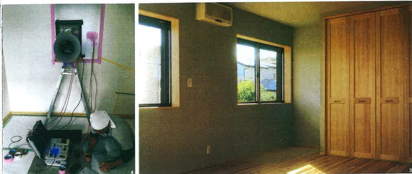
3. たくさんあった間仕切りを取り払い、広くて開放的な空間に。以前の住まいだと隅々までエアコンの風が行き届かず部屋を区切るざるを得なかったが、断熱改修をしたことで保温力が向上し、少ないエネルギーで家中の室温が整う 4. 断熱材をすき間なく施工できているかを調べる気密測定をリノベーションでも実施。新築同等のC値を実現
