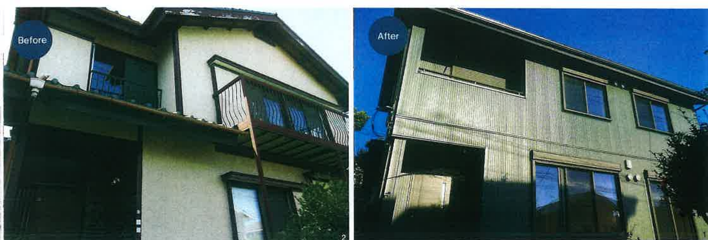
1・2. 築45年の既存住宅をリノベーション。耐震性がなく、断熱材も入っていなかったが、骨組みだけを残し、外部や内部を一から作り直す「スケルトンリフォーム」を施すことで、現代の新築レベルの高性能化を実現。シャープな外観に太陽光パネルも搭載し、省エネな暮らしをかなえた
